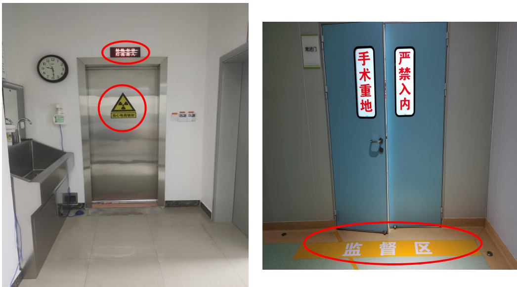
图 4-3 本项目污物通道防护门当心电离辐射警示标志及地面警戒线
